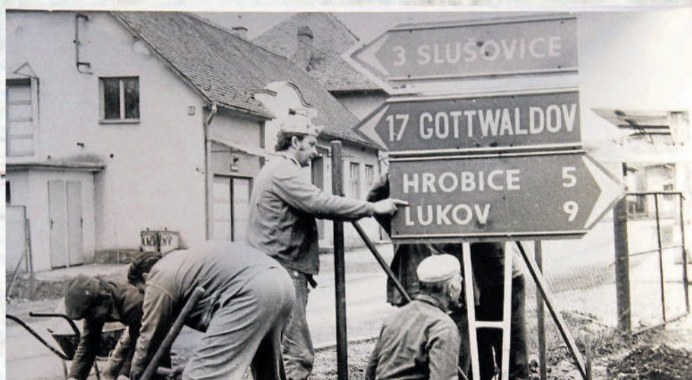
VÝSTAVBA CHODNÍKU 70. LÉTA. Dřívější brigáda neboli „akce Z“, v rámci níž vznikl v Neubuzi nový chodník. Jeho výstavbu prováděli místní obyvatelé. Na snímku je vidět i budova obecního úřadu a hasičské zbrojnice.
